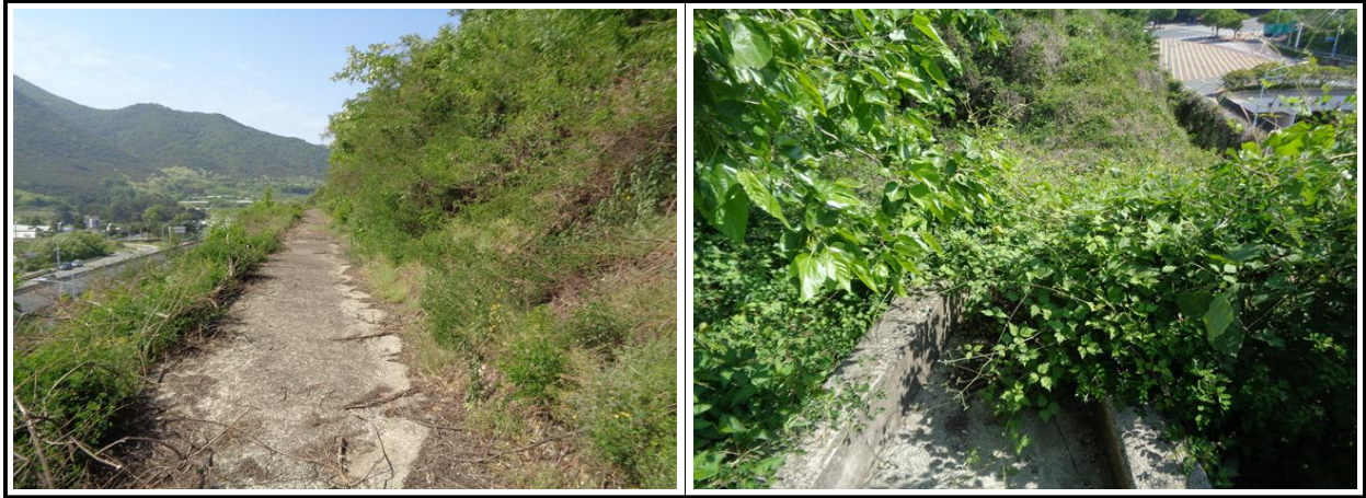
【그림 1.3.7】배수시설 전경
